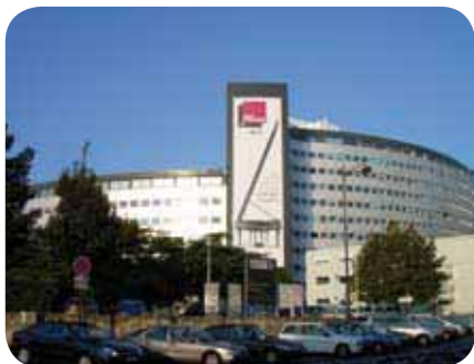
Maison de Radio France, construite en 1963, est l'un des premiers chantiers géothermiques urbains français.
