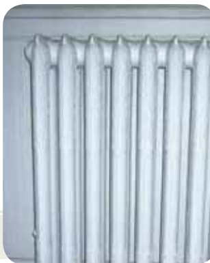
Installation d'une pompe à chaleur avec maintien du réseau de chauffage existant (ici radiateur fonte).
