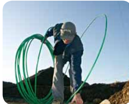
Pose de capteurs horizontaux.
