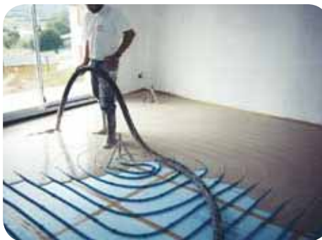
Finition chauffage au sol.
