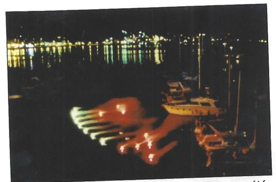
Une matérialisation des contours de l'épave a été réalisée en positionnant des balises exactement à la verticale des extrémités de membrures. Le photographe était juché sur la nacelle d'une grue. De nuit, ces balises ont été éclairées par pyrotechnie. On observe nettement les contours de la coque résiduelle
